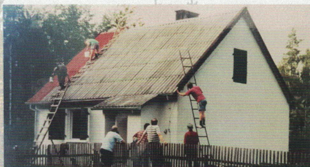
Remont Gajówki. Rok 1997
